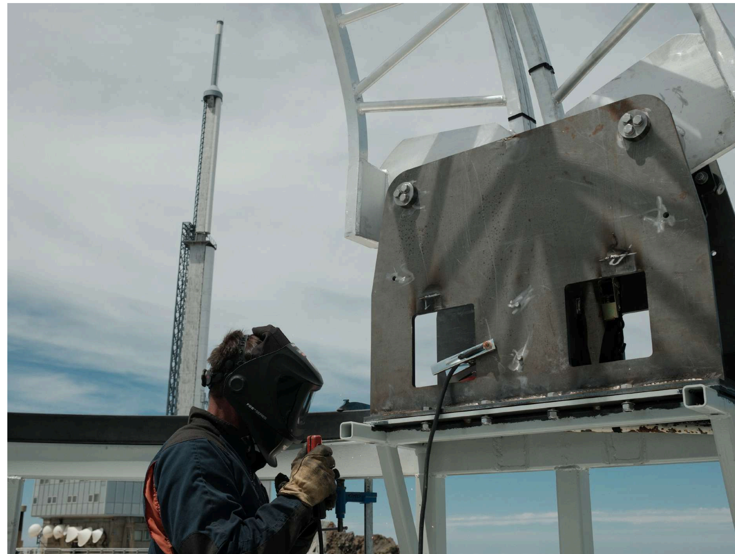
Fixation de la coupole au fût Pic du Midi de Bigorre - 22 juillet 2025
