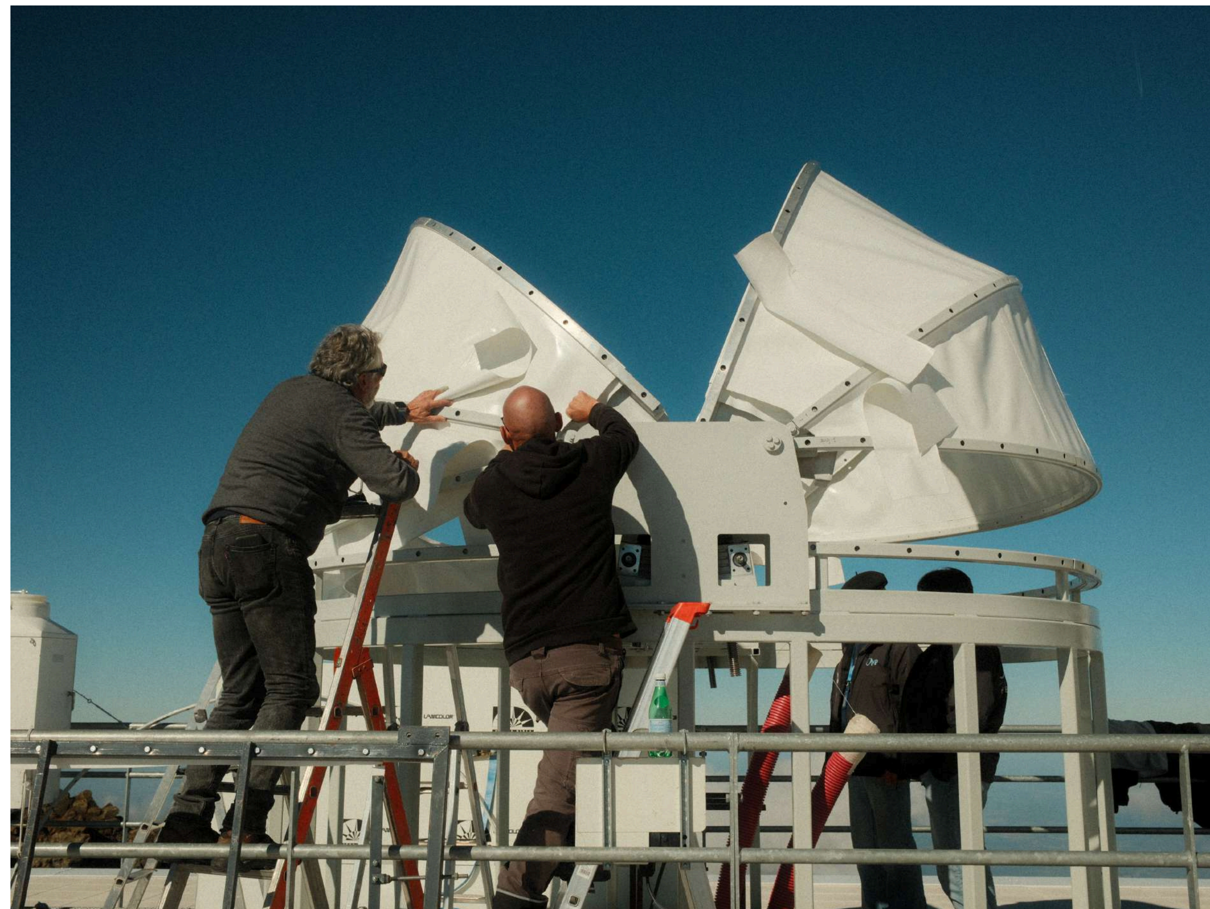
Mise en place des vérins - pose des premières sections de toiles Pic du Midi de Bigorre - 16 et 17 octobre 2025
